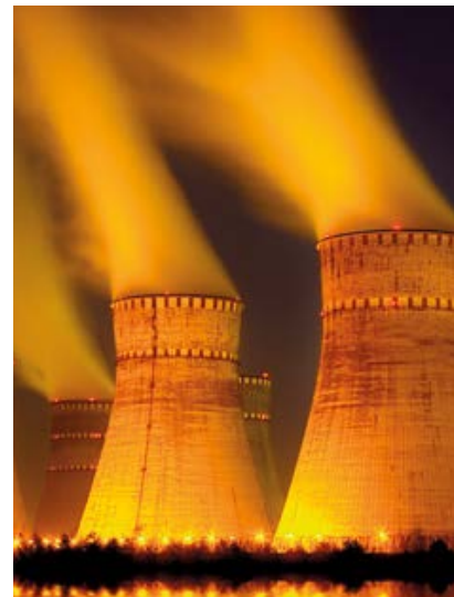
Производство и распределение электроэнергии: ТЭЦ, ГЭС, ГРЭС, АЭС и др.
