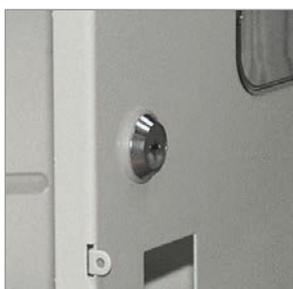
Оперативная панель, закрывающая электросчетчик и электроаппараты. Панель крепится к корпусу при помощи петель и запирается индивидуальным замком.
