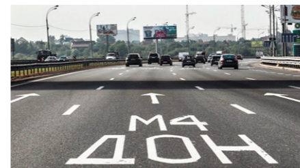
Федеральная автомобильная дорога М4 «Дон»
