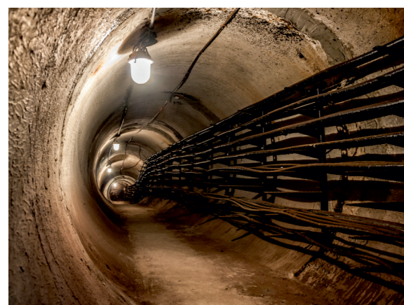
Решения для прокладки подземных коммуникаций
