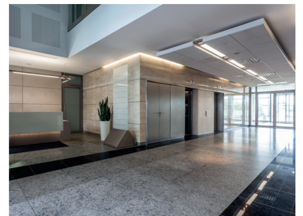
Зал: линейные светильники 1501, эвакуационные указатели ССА
